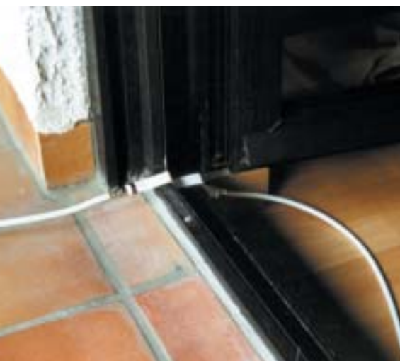
Das Sat-Kabel sollte in jedem Fall mit Kabelschellen und Kabelbinder befestigt werden
