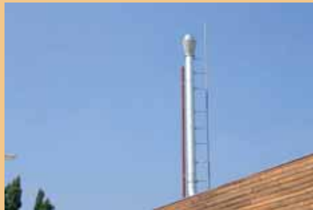
Bild 3: Fallbeispiel einer getrennten Fangeinrichtung.
