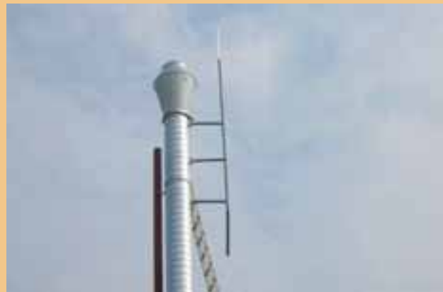
Bild 2: Installation einer getrennten Fangeinrichtung mit isolierter Ableitung an einer metallenen Abgasanlage in einer baulichen Anlage.
