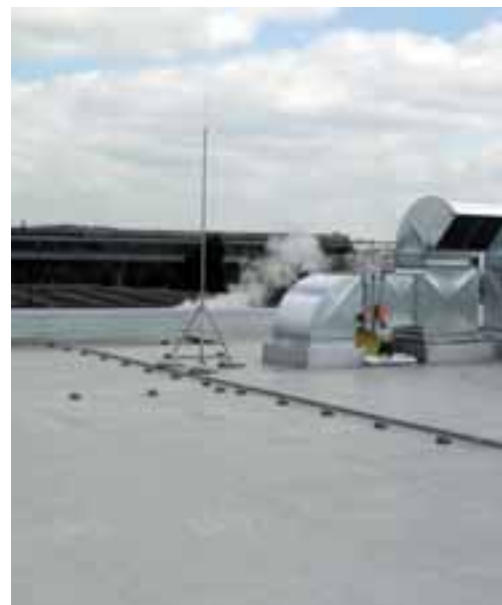
Fangmast zur Absicherung von Klimageräten.
