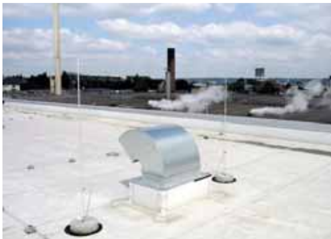
Fangstangen zur Absicherung niedriger Aufbauten.
